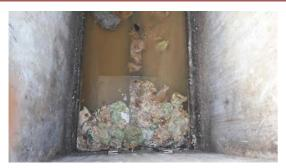
Nous constatons encore trop régulièrement des lingettes et autres déchets solides qui entraînent un dysfonctionnement à la station d'épuration.
